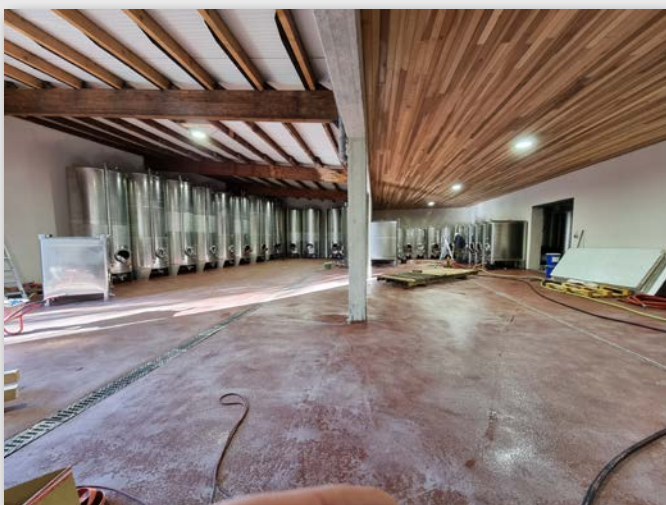
Der Boden ist versiegelt und die ersten Tanks stehen!
